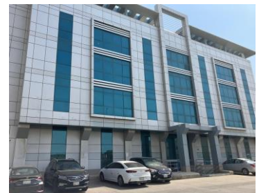
支店が入居する建物の外観
