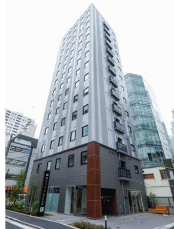
変なホテル東京 浜松町 外観
