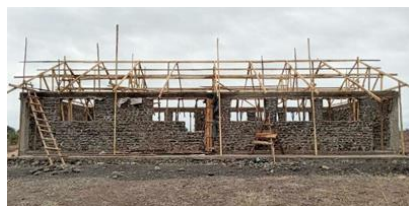
2022年8月 重機は使わず全て手作業の工事です。
