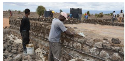
2022年7月 石を積み重ねセメントで固め壁造り。
