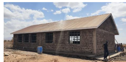
2022年9月21日 外観が完成し室内を整えました。
